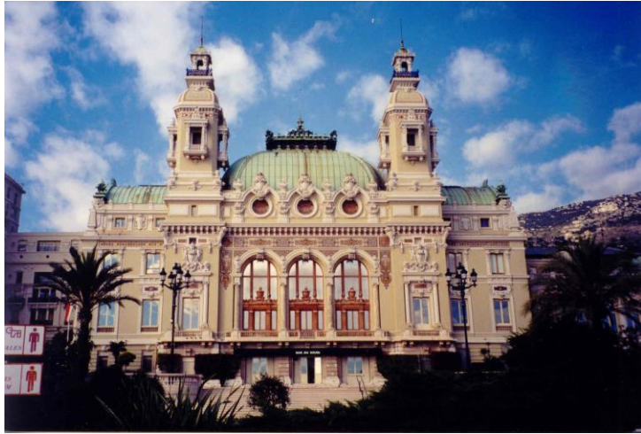
Casino de Monte-Carlo, Monaco
